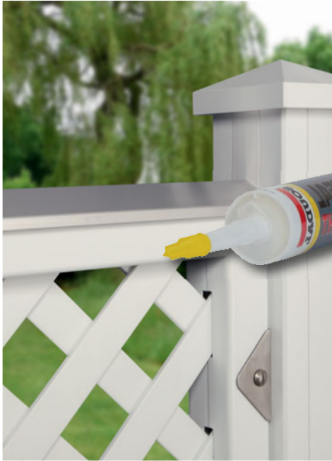
Designaufsatz Alu mit MS-Polymer-Kleber (1398) befestigen.
