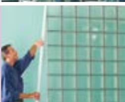
9. Dieser Schritt beendet den Bau der Wand. Sie können nun die noch sichtbaren Seiten der Glasbausteine mit farblich passenden Abschlussleisten aus Holz, Kunststoff oder Metall verkleiden.
