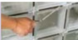
3. Die Fugen und seitlichen Randstreifen (U-Profile) werden Reihe für Reihe mit Mörtel verfüllt und verdichtet. Verlegekreuze als Abstandhalter für 10 mm Fugen gewährleisten ein gleichmäßiges Fugenbild.
