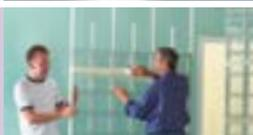
3. Ab einer gewissen Höhe und Breite mit Klebebändern stabilisieren.
