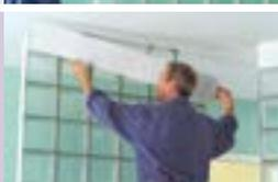
7. Verblendung zur Decke und Abdeckung der Seiten mit Profilen aus Holz, Kunststoff oder Metall.
