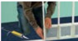
2. Langprofile werden senkrecht verklebt (1 x 1 m und 1 x 0,5 m – statischer Kraftversatz).
