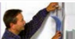
1. Zuerst werden seitlich und oben geeignete Halte-Profile angebracht, z. B.: Randel-Startleiste 90 x 50 x 3 mm, Alu-Winkel-Profile 50 x 50 x 3 mm. Profile innen mit einem Gleitlager (dünne Folie) auskleiden, anschließend einen Dehnstreifen (Styropor mind. 10 mm, Estrich-Randstreifen) zur Wand- und Deckenseite einlegen.
