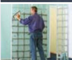
8. Wenn die Wand komplett fertig gestellt und der Kleber 24 Stunden getrocknet ist, verfüllen Sie die Fugen mit flexiblem Fugenmörtel passend zur Farbe Ihrer Glasbausteine. Wand- und Bodenfuge müssen beidseitig dauerhaft elastisch ausgeführt werden!
