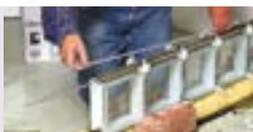
2. Am Rohboden wird auf einem Gleitlager (doppelte Baufolie) in einer Schalung ein Randstreifen (Mörtelbett 50-100 mm) zur Aufnahme der ersten Glasbaustein-Reihe erstellt. Mörtel: Leichtmörtel, Zementmörtel (1:4-1:5), Glassteinfertigmörtel. In den Randstreifen und den waagerechten Fugen muss zur Stabilität Bewehrungs-eisen verzinkt oder Edelstahl Ø 6 mm bis in die U-Profile eingelegt werden.
