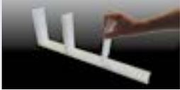
4. Sobald der untere Teil positioniert und mit Schrauben befestigt worden ist, mit dem Einstecken der vertikalen Abstandhalter in die Bindeglieder fortfahren, um die regelmäßigen Fugen zwischen den Glasbausteinen zu erhalten.
