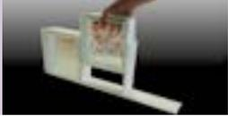
5. Die Glasbausteine zwischen die vertikalen Abstandhalter setzen, bis die Reihe vervollständigt ist.
