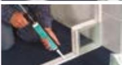
4. Nehmen Sie nun das erste vertikale Profil und tragen beidseitig den QUICKTECH Kleber gleichmäßig auf die komplette Profillänge auf.
