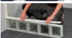
6. Nach Fertigstellung der ersten Schicht tragen Sie den QUICKTECH Kleber gleichmäßig auf das horizontale Profil auf und setzen dies waagrecht auf die Glasbausteine.
