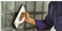
4. Nach dem Trocknen der Wand (1-2 Tage) werden die zurückgesetzten Mörtelfugen mit Flex-Fliesen Fugen-breit verfügt.
