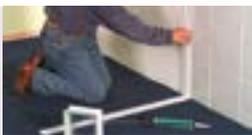
2. Tragen Sie den QUICKTECH Kleber auf das Fußbodenprofil und das Wandprofil auf. Befestigen Sie die Profile an der Wand und am Fußboden. Dann tragen Sie den Kleber auf einem Abschnitt von mehr als 20 cm gleichmäßig auf die Oberfläche des Fußboden bzw. Wandprofils auf.
