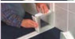
5. Stellen Sie das vertikale Profil senkrecht auf das Fußbodenprofil gegen den ersten Glasbaustein und wiederholen anschließend die Schritte 2 bis 5.
