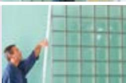
6. Dieser Schritt beendet den Bau der Wand. Sie können nun die noch sichtbaren Seiten der Glasbausteine mit farblich passenden Abschlussplättchen bzw. Abschlussleisten aus Holz, Kunststoff oder Metall verkleiden.
