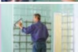
5. Wenn die Wand komplett fertig gestellt und der Kleber 24 Stunden getrocknet ist, verfüllen Sie die Fugen mit flexiblem Fugenmörtel passend zur Farbe Ihrer Glasbausteine.
